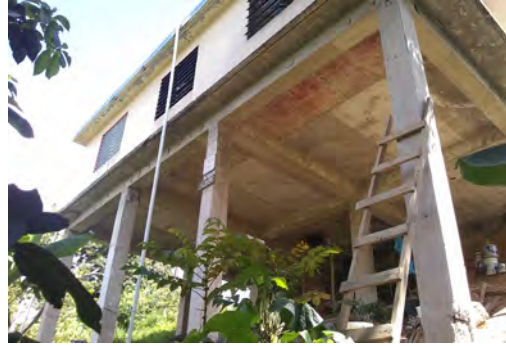
Casa de 2 pisos hecha en bloques y concreto
