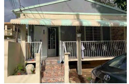
Casa hecha en madera con fundación en concreto
